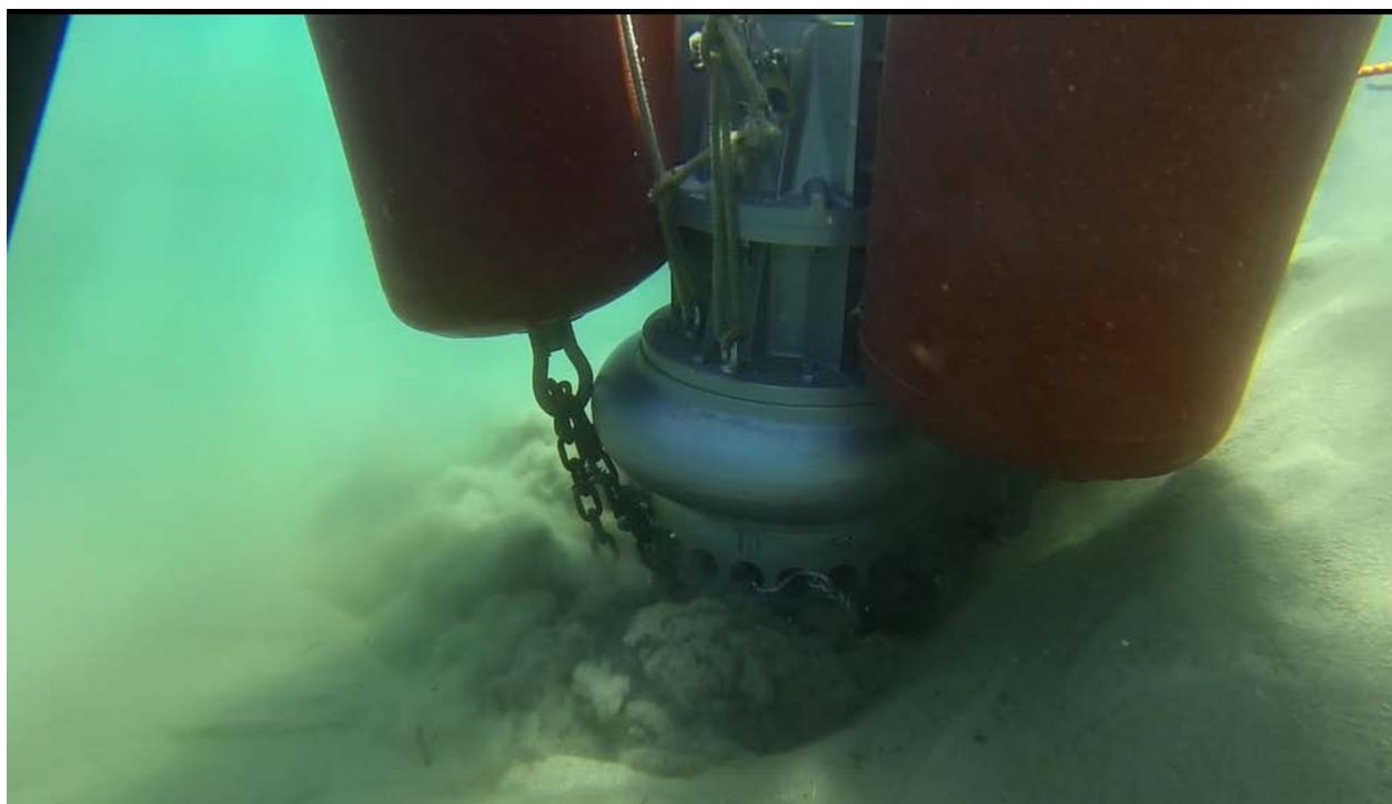
Figura 28 pompa Dragflow durante i lavori di rimozione dei geotubi
